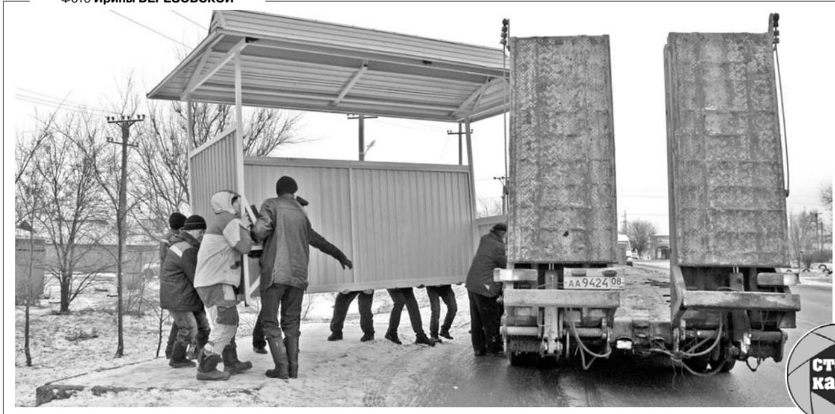
В Элисте продолжают мероприятия по обустройству автобусных остановок. Так, вчера в западной части калмыцкой столицы на пересечении улиц Ленина и Шар-Баргс был установлен новый остановочный павильон. Конструкция в восточном стиле выполнена из металлического каркаса и поликарбоната сотрудниками МБУ "Городское зеленое хозяйство".
